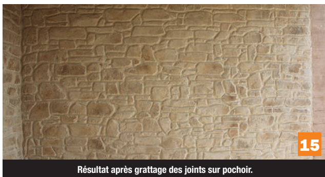
Creuser les joints.
